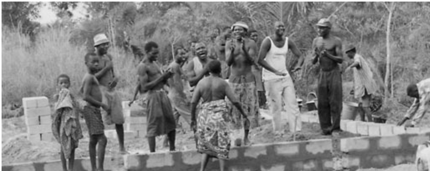
Al ritmo della "maman africana" si prepara la base per l'istallazione del depuratore
